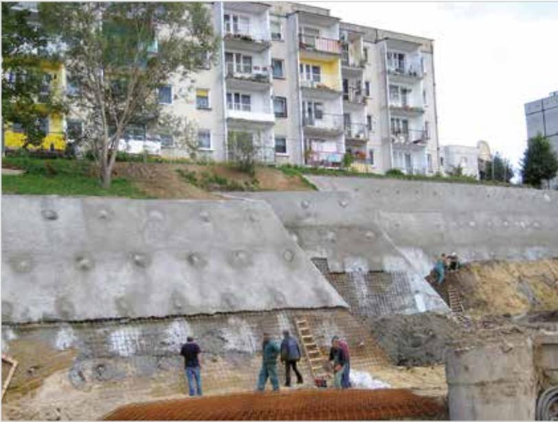
**Protección superficial mediante armadura y hormigón proyectado**
