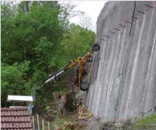
**Rehabilitación de los anclajes de un muro de contención**
